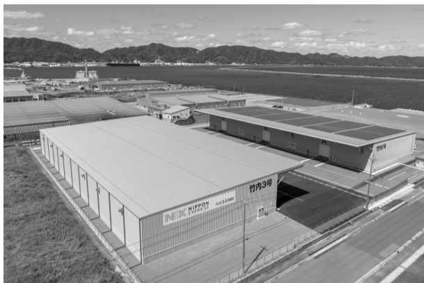
増加する貨物を保管するために建設された竹内3号倉庫
