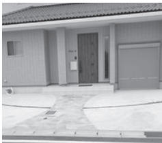
完成後の駐車場と玄関周辺
