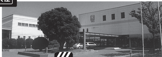
本社・第一工場
